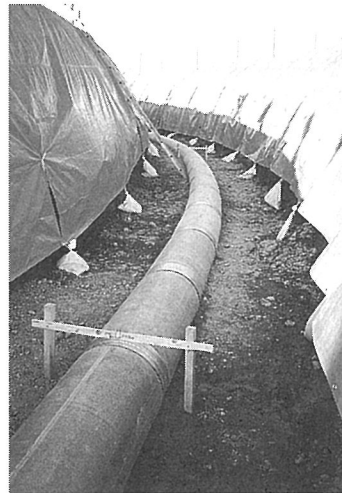
写真-6 開削状況
