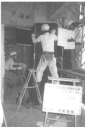
写真-4 炭素繊維シート巻き施工状況
