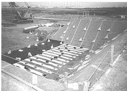
写真-1 盛り立て直前の状況（4工区）
