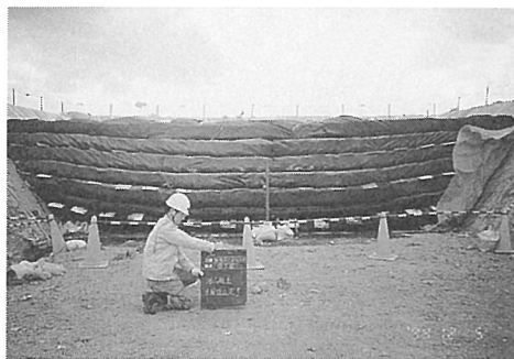
写真-2 盛り立て8層目完了時（4工区）
