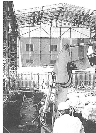
写真-6 本工事（基礎掘削）
