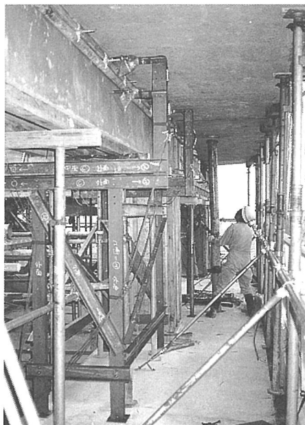
写真-1 計測状況
