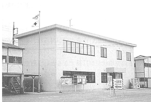
写真-7 竣工後の全景
