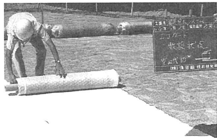
写真-1 エコガード施工の様子
