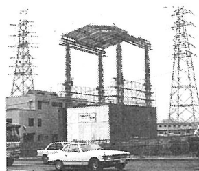
写真-10 クライミング状況 ( h=23\text{m} )
