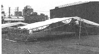
写真-7 屋根のシート張り
