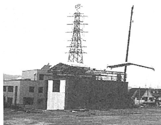
写真-8 屋根架設
