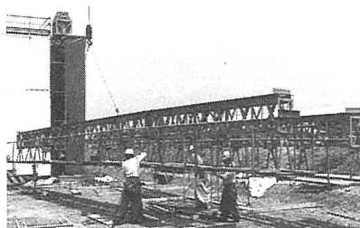
写真-5 桁梁の地組み
