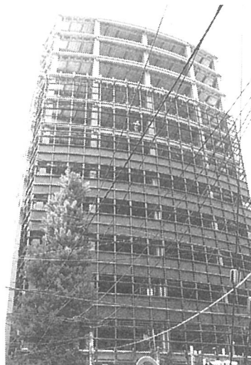
写真－1 測定時の建物の外観
