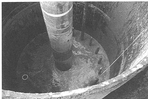
写真-2 杭頭処理中の杭頭状況
