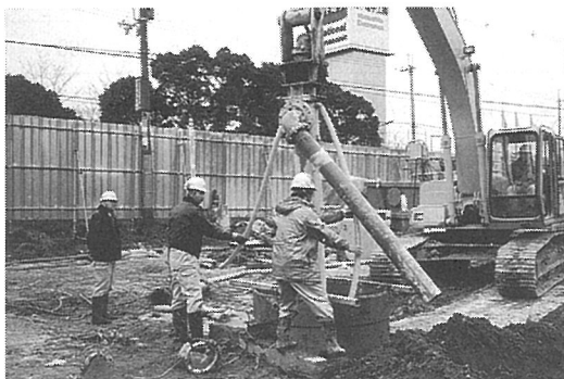
写真-1 杭頭処理施工の状況
