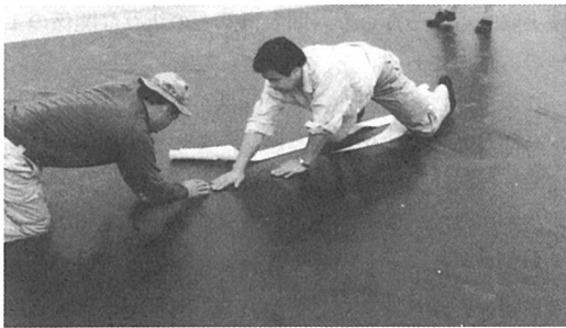
① 防根シートの施工
