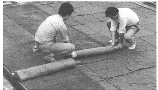
⑤ 先行植生芝の施工
