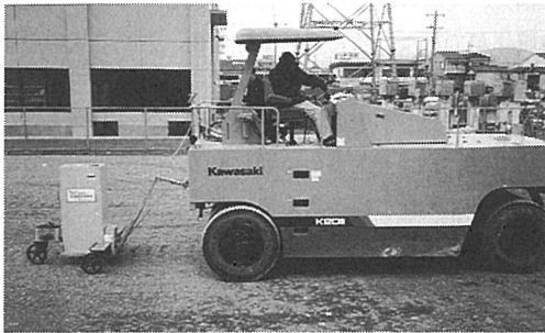
写真-4 自動締固め管理装置の稼働状況
