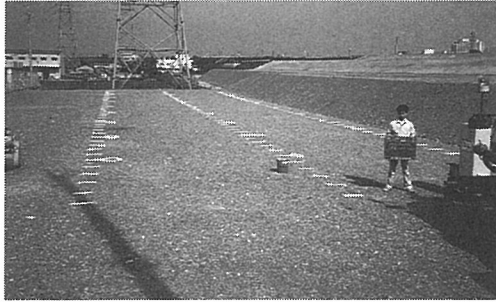
写真-3 施工管理を行った区域の全景
