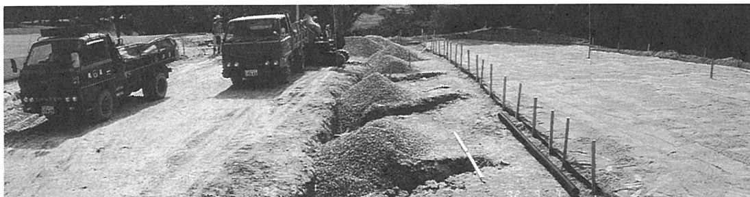
ゴルフ場での実験施工全景
