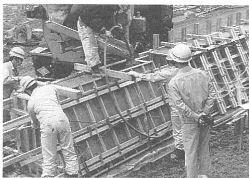
写真-1 コンクリートの打設状況
