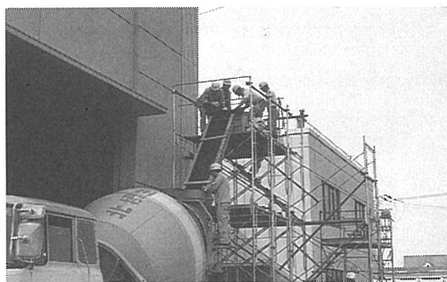
写真－1 SF投入足場
