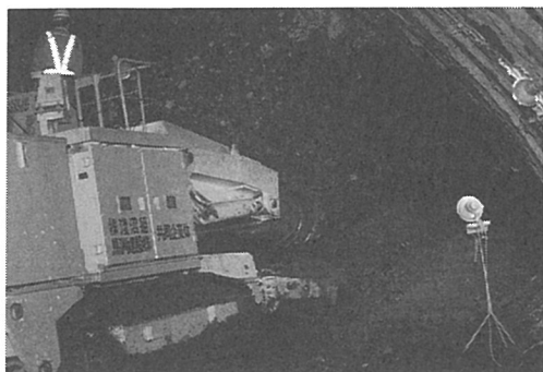
写真－２ 機械掘削状況
