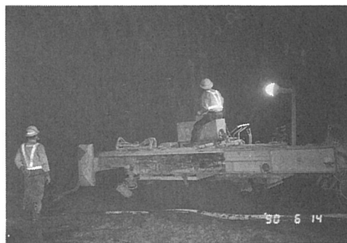
写真－４ 吹き付けコンクリート 打設状況
