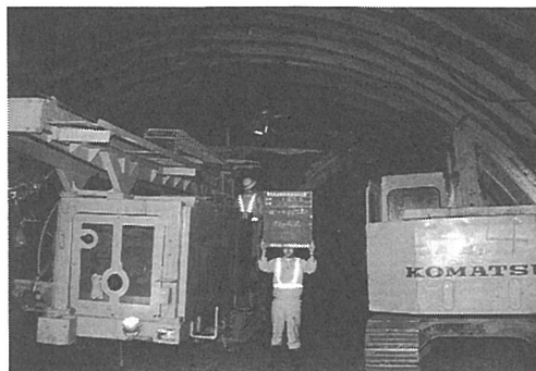
写真－３ H鋼支保工建て込み状況
