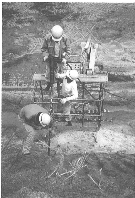
写真-6 鋼管打設状況
