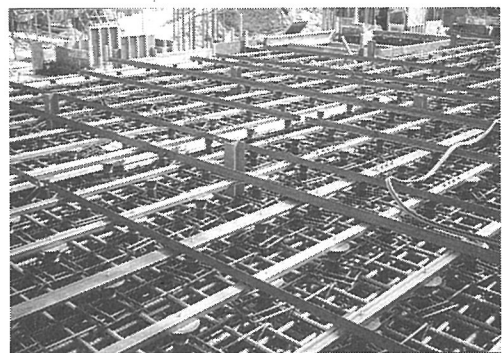
写真-3 定着孔スリーブ管取付け
