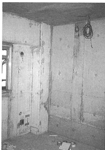
写真－２ 断熱材復旧および天井センサー打込み配線－仕様(2)
