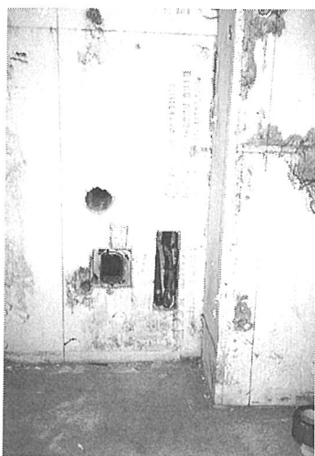
写真－１ 断熱材切り込み後、温・湿度センサー設置－仕様(2)
