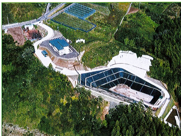
長野県北信保険衛生施設組合 (大俣処分場)
