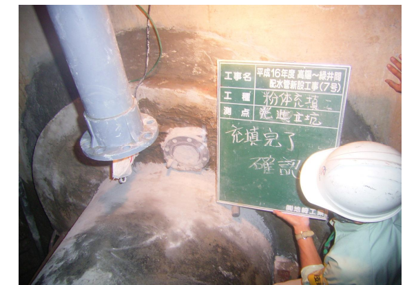
充填完了確認
