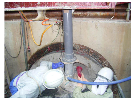
充填状況確認
