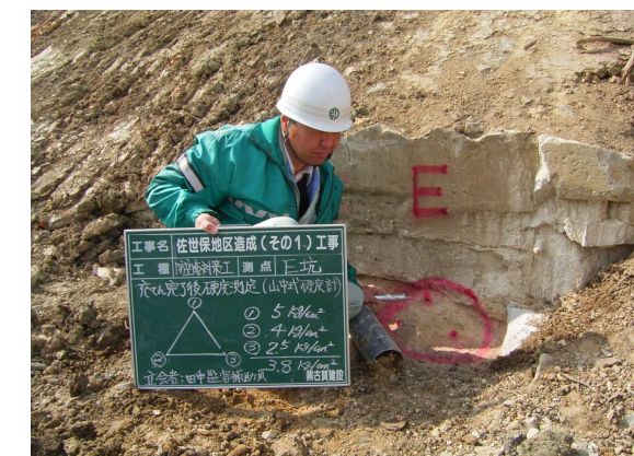
充填完了確認
