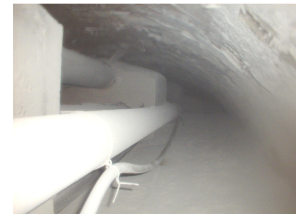
管内充填状況
