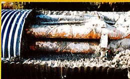
充填完了確認
