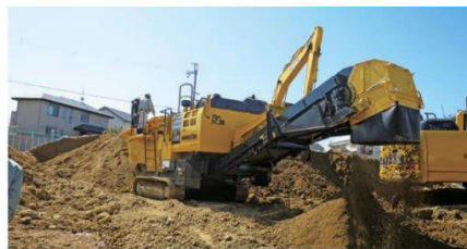
リテラによる建設汚泥の自ら利用
