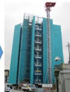
浅沼組の工事現場
