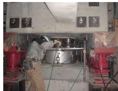
免震装置の挿入状況
