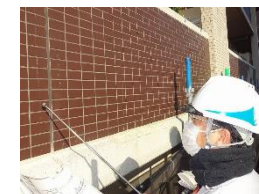
外壁タイルの長期点検制度
