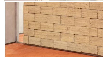
間仕切壁施工事例 (名古屋支店)
