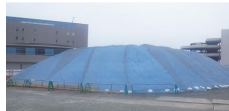
掘削土の場内仮置きによる再利用
