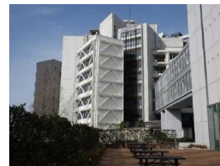
仕上がり外観
