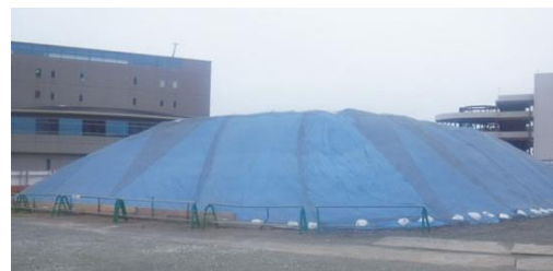
掘削土の場内仮置きによる再利用
