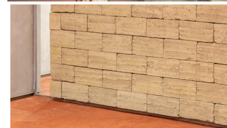
間仕切壁施工事例 (名古屋支店)
