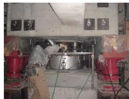
免震装置の挿入状況
