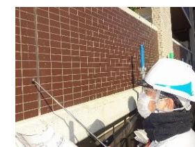
外壁タイルの長期点検制度
