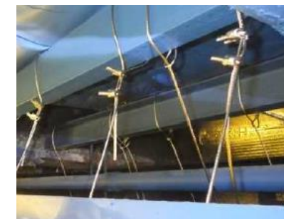
天井落下防止対策
