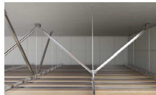
天井耐震工法
