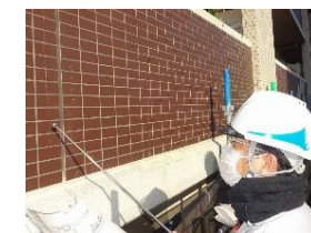
外壁タイルの長期点検制度
