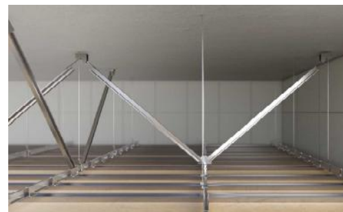
天井耐震工法
