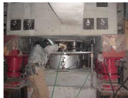
免震装置の挿入状況
