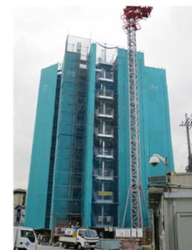
浅沼組の工事現場
