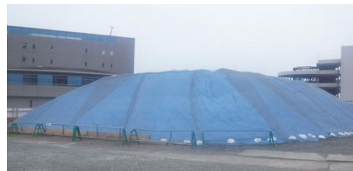
掘削土の場内仮置きによる再利用
