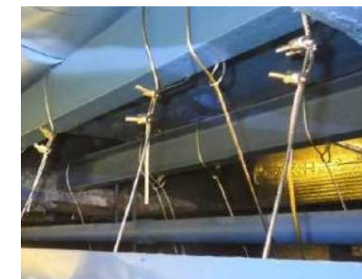
天井落下防止対策
