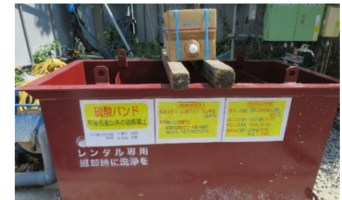
場外排水管理（濁度・PH）
