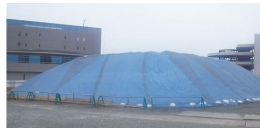
掘削土の場内仮置きによる再利用
