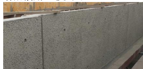
資源循環型コンクリートの施工状況 (コンクリート手摺)
