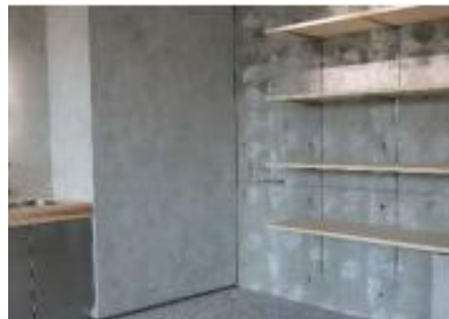
鉄筋コンクリートの耐久性を高めるための 表面処理を実施。
