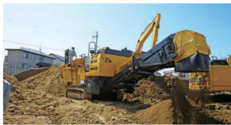
リテラによる建設汚泥の自ら利用
