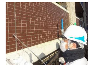
外壁タイルの長期点検制度
