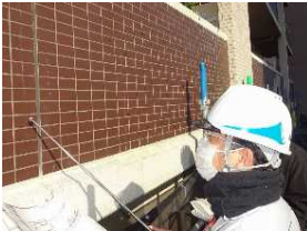
外壁タイルの長期点検制度
