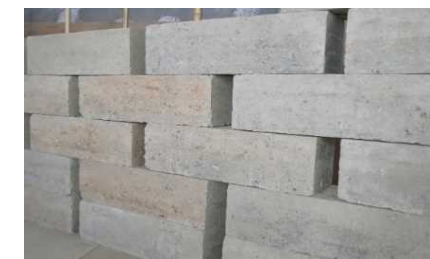
間仕切壁施工事例
