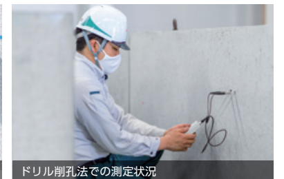
ドリル削孔法での測定状況
