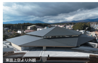
東面上空より外観
