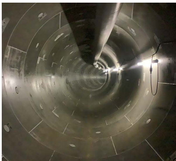
バイパス管完成
