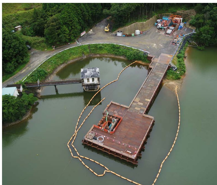
施工箇所(全景)
