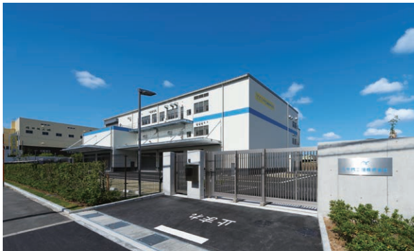
外観北東面全景
