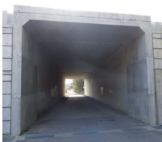
プレキャストカルバート工
