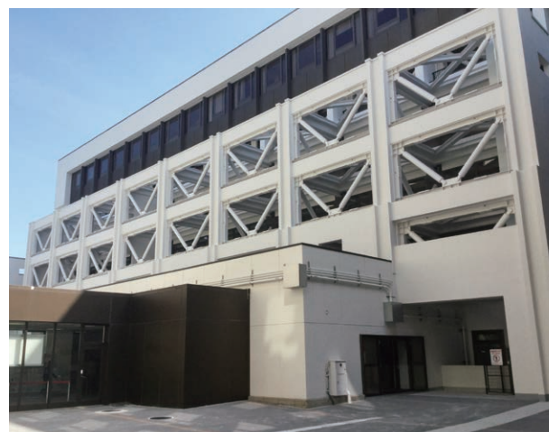
中央棟(北側)外付けフレーム
