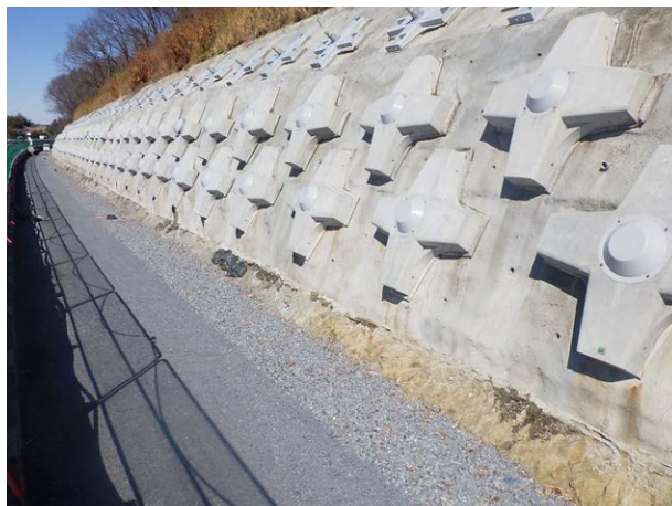
モルタル吹付工、グラウンドアンカー工
