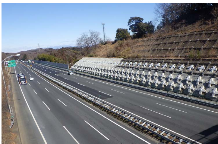
モルタル吹付工、グラウンドアンカー工
