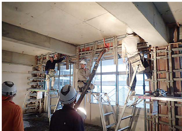
スムーズフィルクリート打込み(圧入)状況
