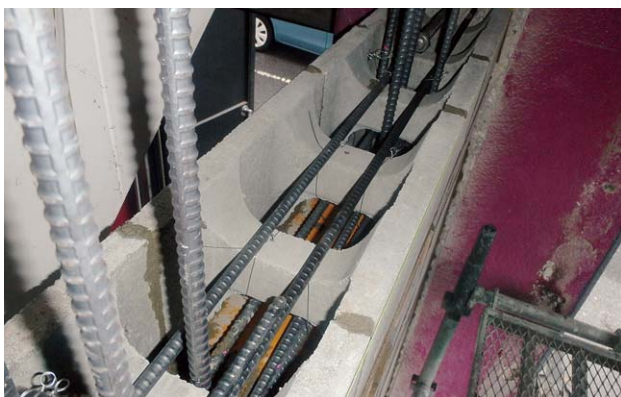
RMユニット組積状況
