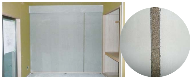
① 戸境壁ひび割れ誘発目地PRS充填
