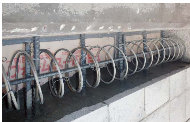
梁下充填部の補強筋
