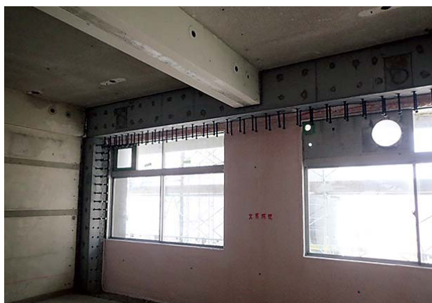
スムーズフィルクリート打込み後(型枠脱型後)の状況
