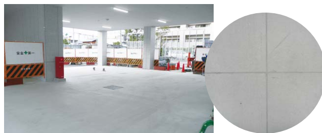
② 土間床カッター目地PRS充填(色合せ)
