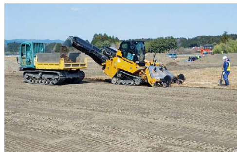
スキマーによる表土剥取り
