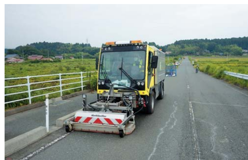
ラジカル工法による路面除染
