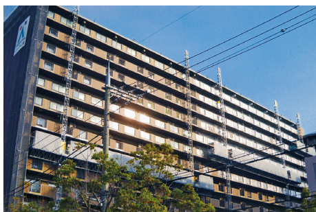
リフトクライマー南面外観
