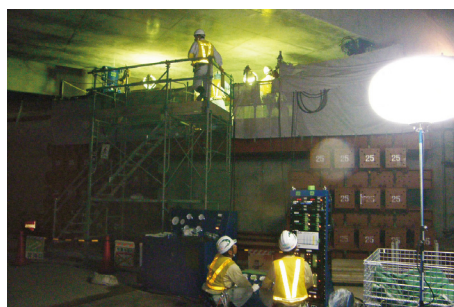
ジャッキダウン工法（施工管理）
