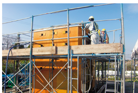
現場実大模型実験
