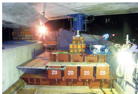
ジャッキダウン工法（設備）
