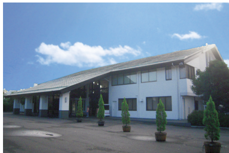
完成（クラブハウス西面外観）
