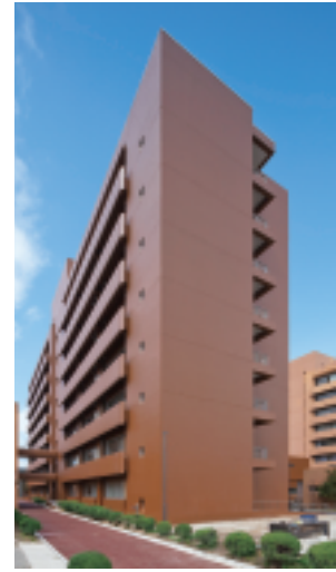
改修工事完了後
