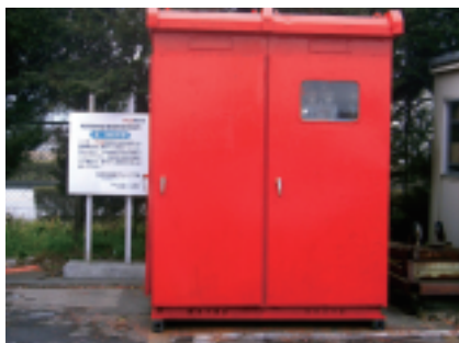
PCB 保管庫外観
