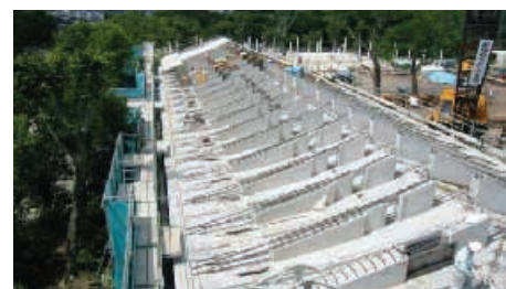
■PCa版およびPCa版架設後の状況
