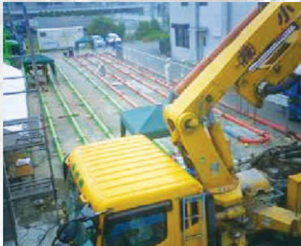
敷き詰められた圧送管
