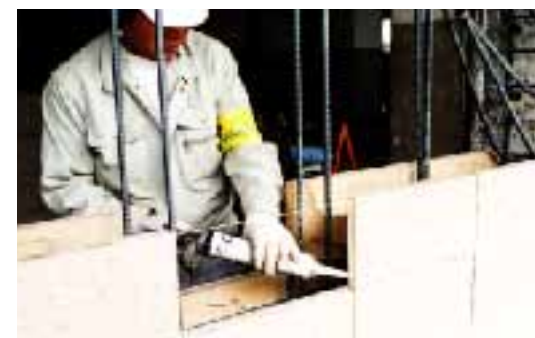
【ユニット組積状況】
