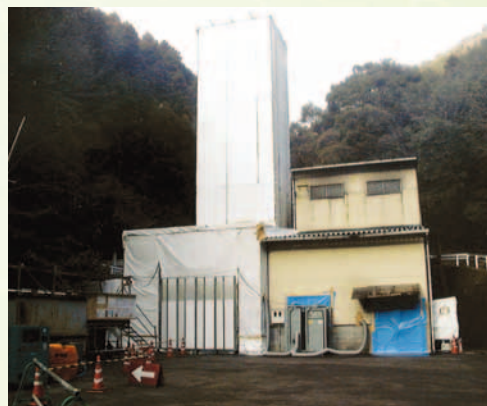
【当社が施工した解体対象の隔離養生】
