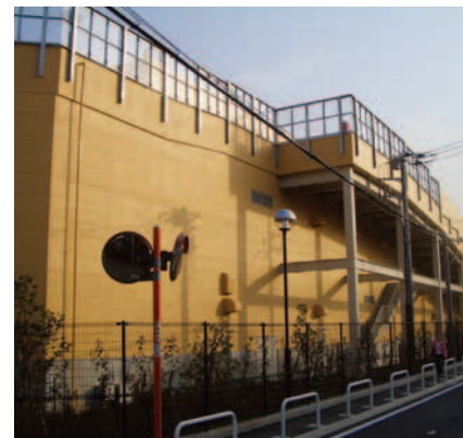
【車路の防音壁】
