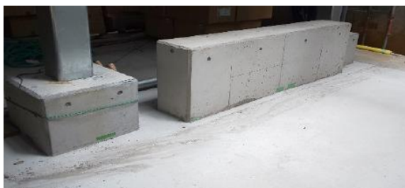
低炭素型コンクリートの施工状況 (屋外階段基礎・土間)
