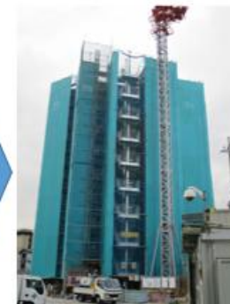
浅沼組の工事現場
