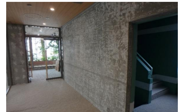
躯体あらわしのまま使用し、RC調査診断 技術で居ながら劣化調査
