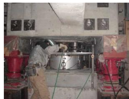
免震装置の挿入状況
