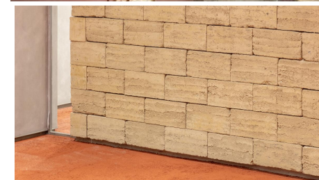
間仕切壁施工事例 (名古屋支店)
