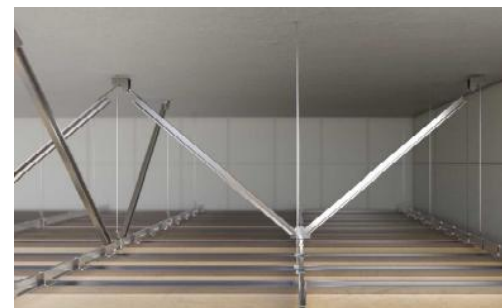
天井耐震工法
