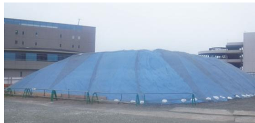
掘削土の場内仮置きによる再利用
