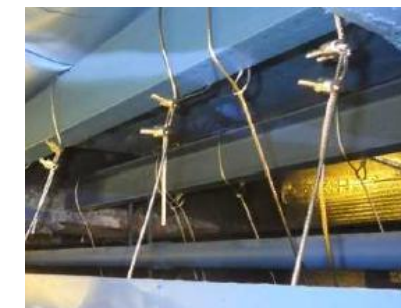
天井落下防止対策
