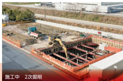
施工中 2次掘削
