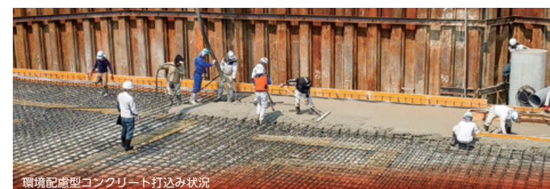
環境配慮型コンクリート打込み状況
