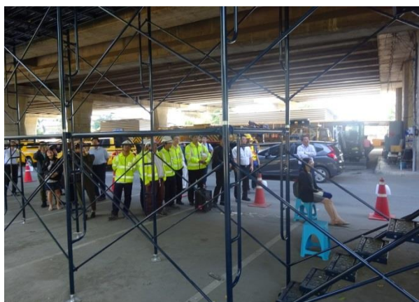
施工デモンストレーション
