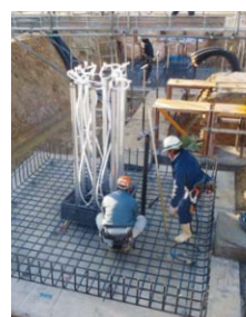
アンカーセット状況
