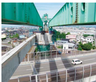
PC桁送出し架設
