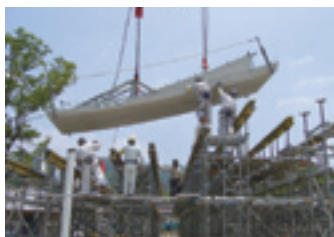
PCaRC版架設中の状態
