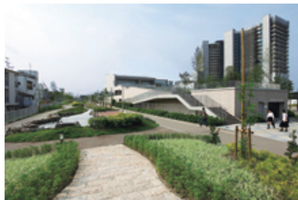
南千里丘コミュニティプラザ・保健センター
